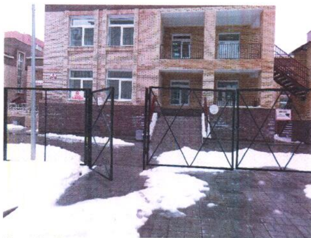
Фото 1 – Вход на территорию Учреждения
